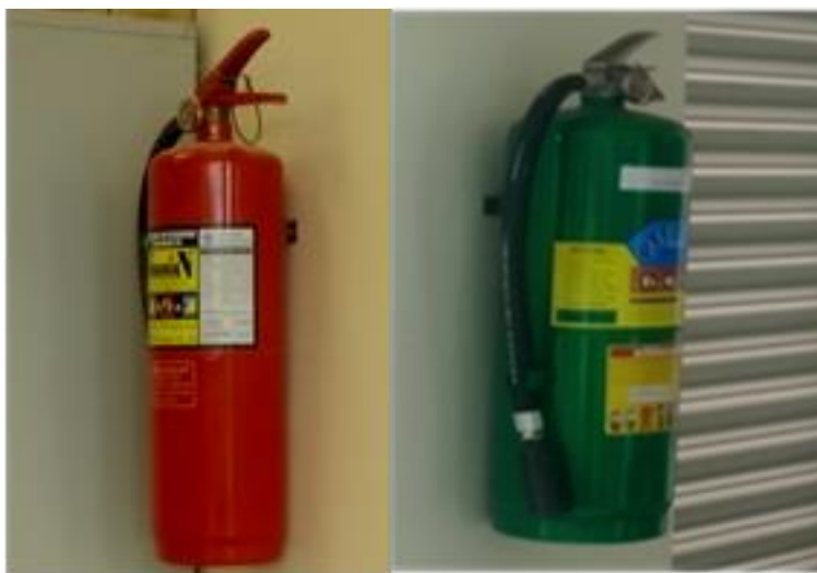
รูปที่ 1 ชนิดของถังดับเพลิง ถังดับเพลิงชนิดผงเคมีแห้ง (สีแดง) ถังดับเพลิงชนิดน้ำยาเหลวระเหย (สีเขียว)
